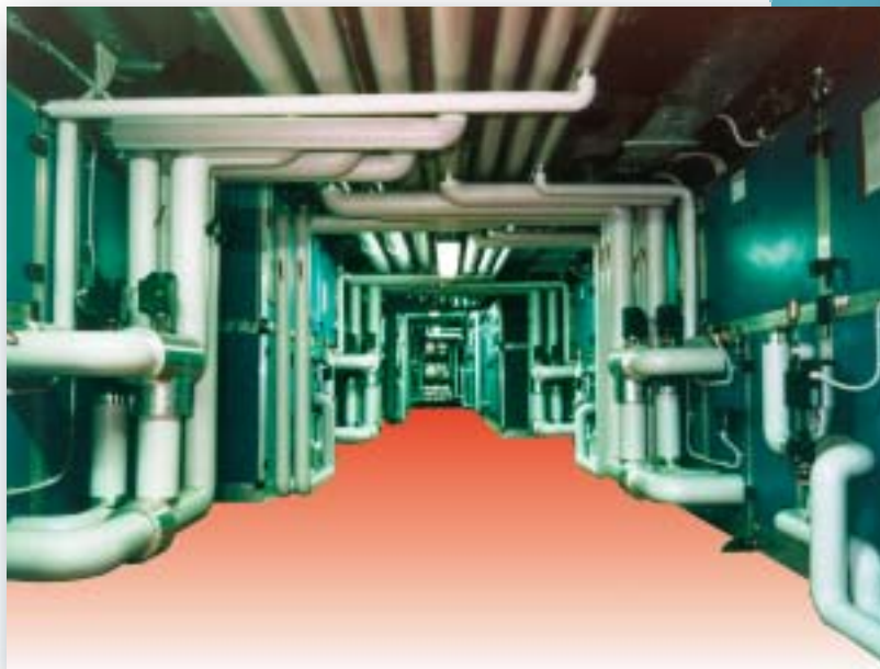
Centrale termica installata presso l'Ospedale S. Raffaele (Milano) Air treatment unit install at S. Raffaele Hospital (Milan)
